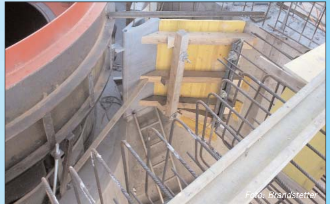
Große Anforderungen an die Zimmermänner: Die Geometrie der Einlaufspirale ist für den Wirkungsgrad von entscheidender Bedeutung. Foto: Brandstetter
