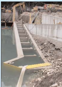
Die Arbeiten am Fischpass schreiten zügig voran. Pass in Vertical-Slot Ausführung.
